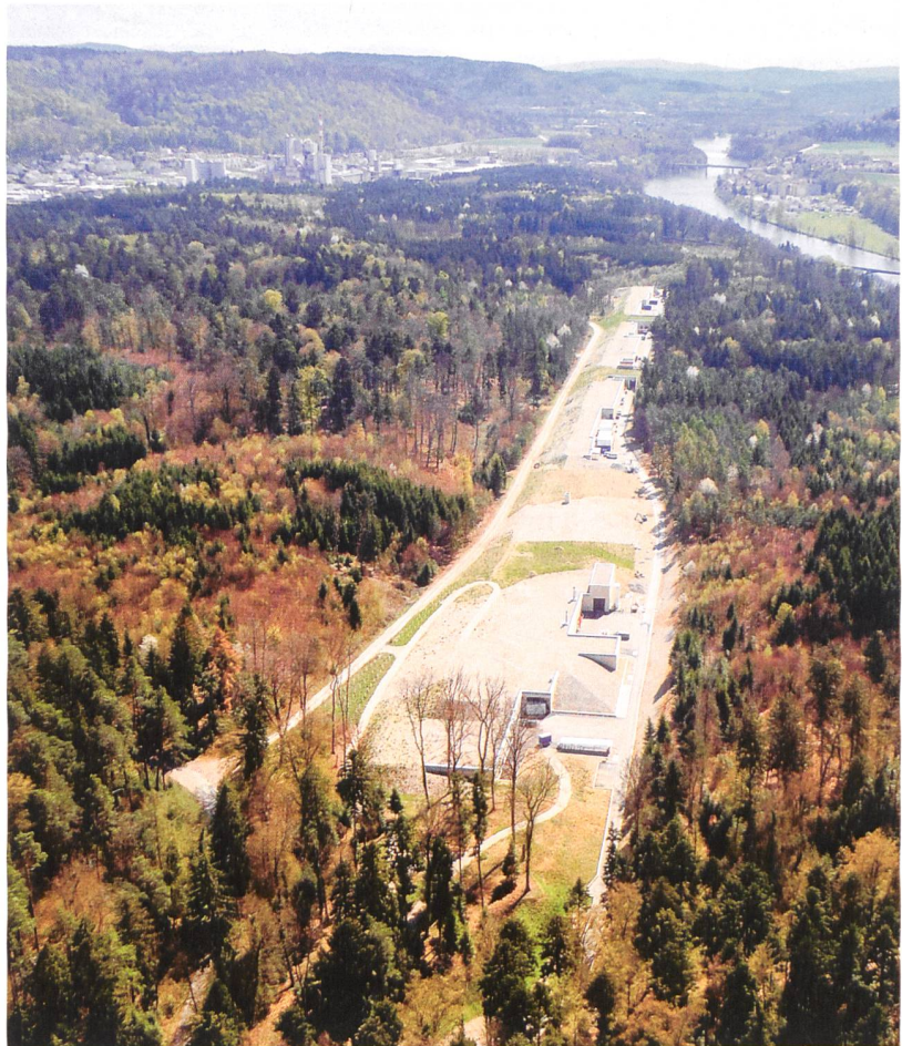
Die komplexe geometrische Vielfalt der Grossforschungsanlage SwissFEL war eine Herausforderung im engen Zusammenwirken aller Planer.
