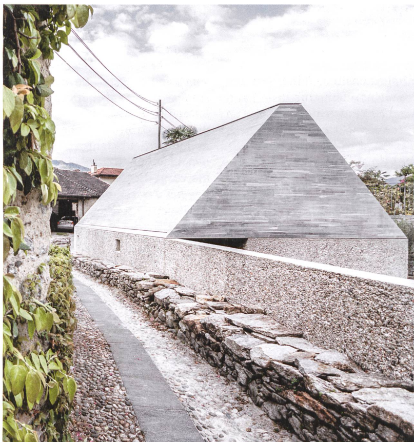
Erweiterung Museum MeCri, Menusio: Die alte Mauer kann in aller Schönheit verfallen, wobei sie nach und nach den Blick auf die neue Linie der Wand aus Waschbeton freigibt.
