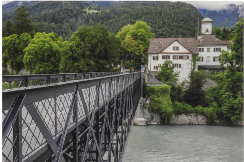
Baukultur meint auch den Erhalt historischer Ingenieurbauwerke – wie etwa der 135 Jahre alten Eisenfachwerkbrücke über den Rhein bei Reichenau GR . Sensibel erneuert wurde die Brücke 2014/15 vom Ingenieurbüro Conzett Bronzini Partner aus Chur.
