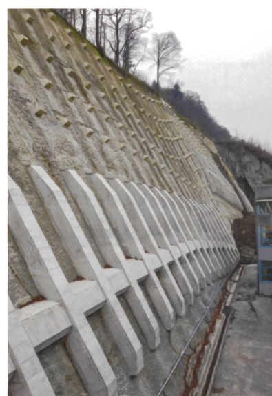
Abgeschlossene Sanierung, Blickrichtung West.
