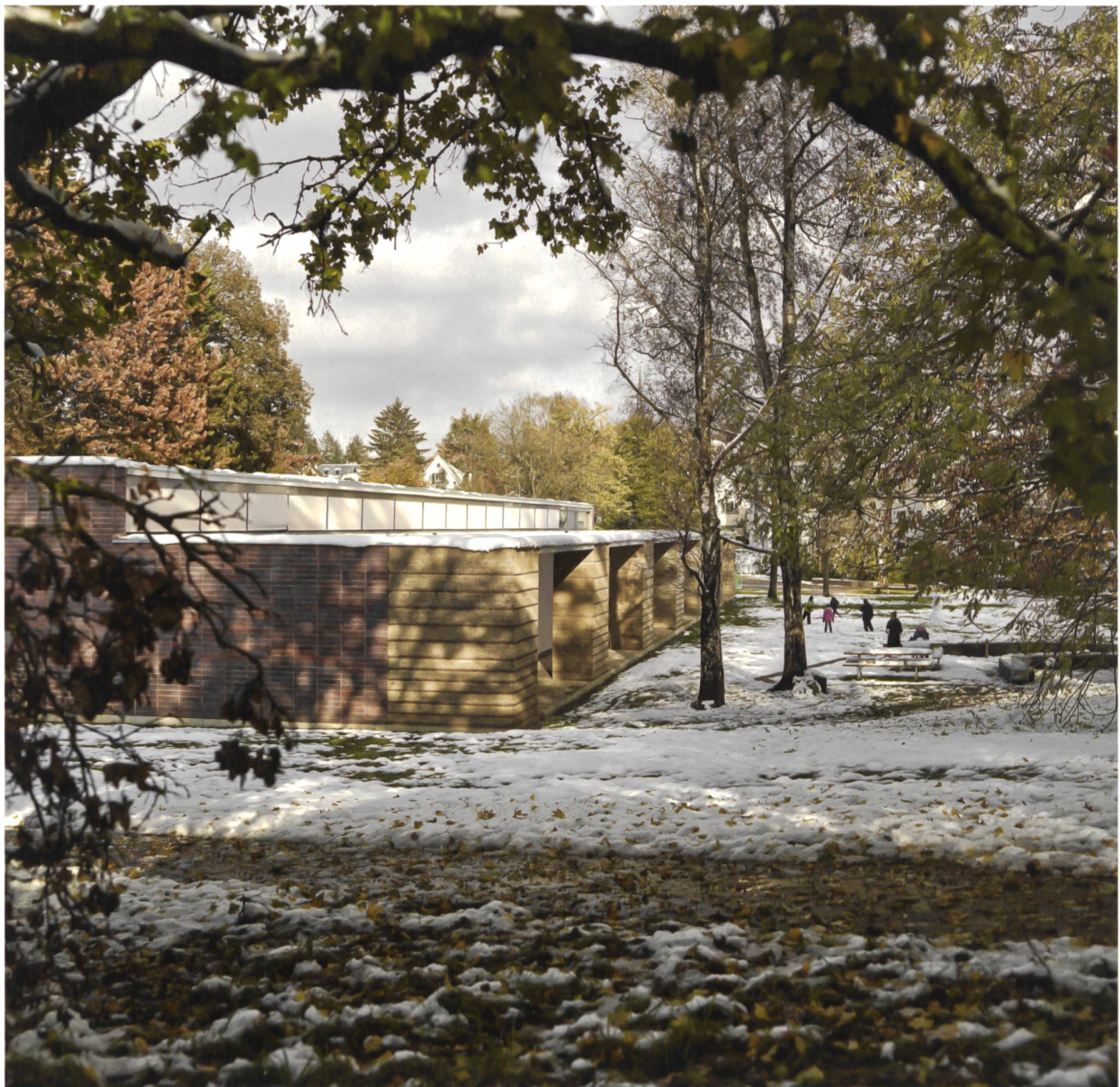
Boltshauser Architekten setzten im Jahr 2012 im Rahmen des Umbaus des Schulpavillons von Jakob Padrutt in Zürich Allenmoos eine Lehmveranda vor die östliche Aussenwand . Der Lehm bewährt sich und wird von Nutzern und der Bauherrschaft geschätzt.
