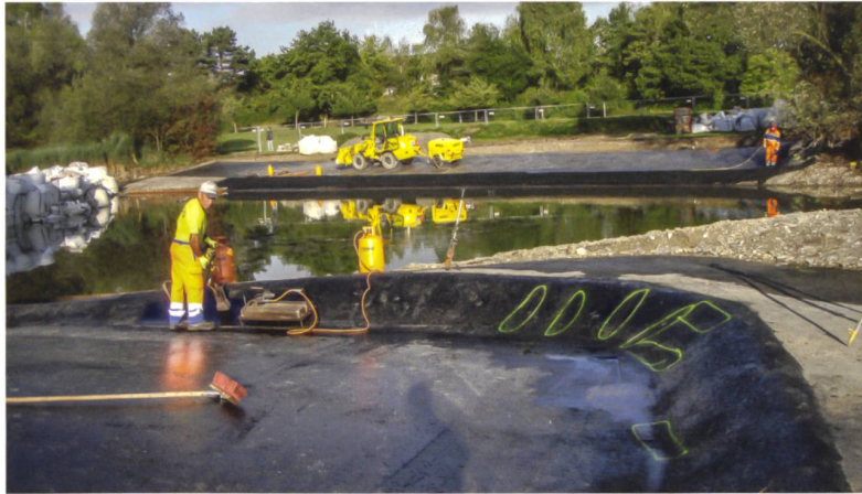
Einbau der Asphaltabdichtung im Uferbereich des Grossweihers.
