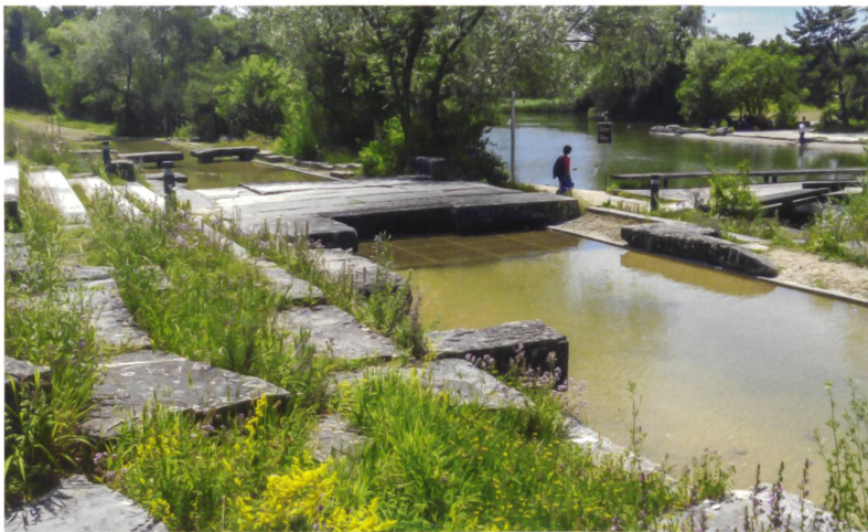
Neu abgedichtet und wieder in den Park eingepasst: der Reflecting Pool . Gitter unter der Wasseroberfläche am Übergang helfen mit, Unfälle zu verhüten.
