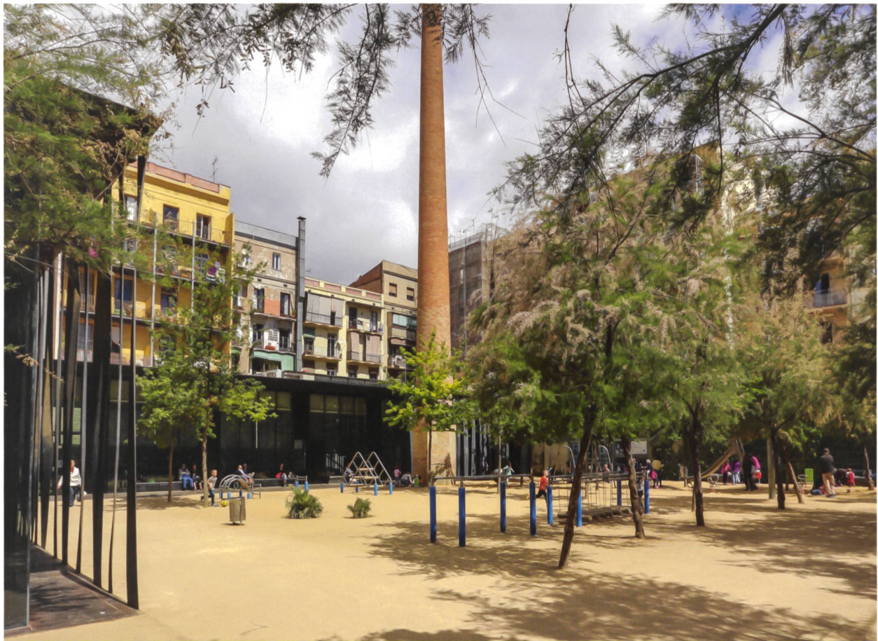
Der Innenhof wird als Spielplatz genutzt und dient zugleich als Zugang zum Seniorenzentrum. Der Industrieschlot der abgebrochenen Fabrik wurde erhalten.
