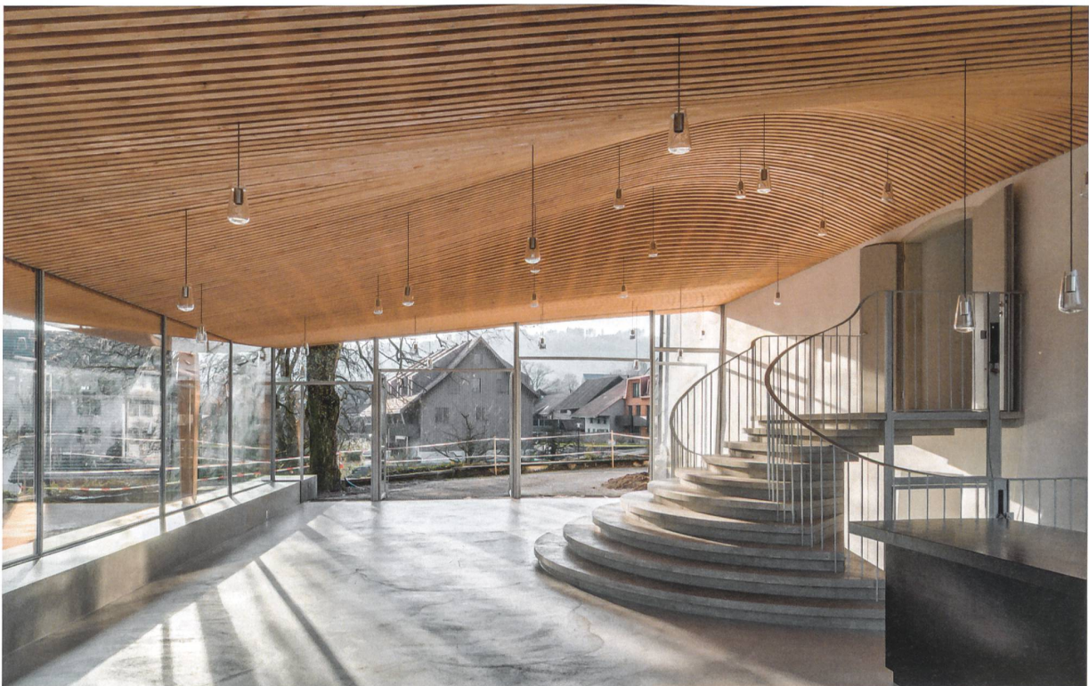
Im Innern wirkt das Foyer offen, und das 9 × 15 m messende Dach wölbt sich leicht über den neuen Treppenaufgang aus Mägenwiler Muschelkalk. Was wie ein leichtes Lattenwerk erscheint ist, in Wirklichkeit die Untersicht des Holztragwerks selber, gebildet aus 46 unterschiedlichen Trägerformen aus Brettschichtholz. Rechts die Holztheke mit Lackierung aus schwarz glänzendem Urushi, an der Decke angehängt die eigens entworfenen, mundgeblasenen Pendelleuchten.
