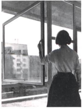
Blick aus dem Fenster des Farelhauses in Biel zur Entstehungszeit Ende der 1950er-Jahre. Die Drehflügel der Fenster an der Strassenfassade mit den Originalbeschlägen konnten im Zuge der aktuellen Erneuerung erhalten werden. Coverfoto zur Verfügung gestellt von Farelhaus AG.
