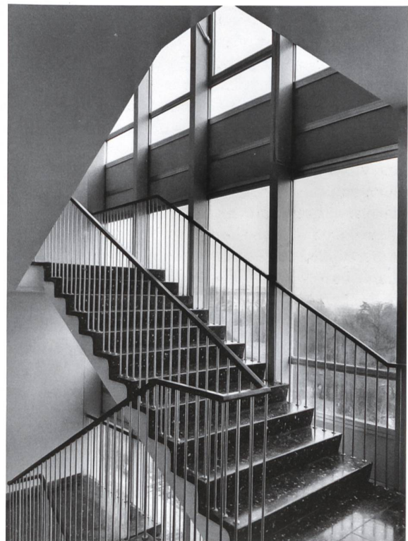
Treppenhaus und Fassade waren in dem seit 2009 unter Schutz stehenden Gebäude auf jeden Fall zu erhalten.
