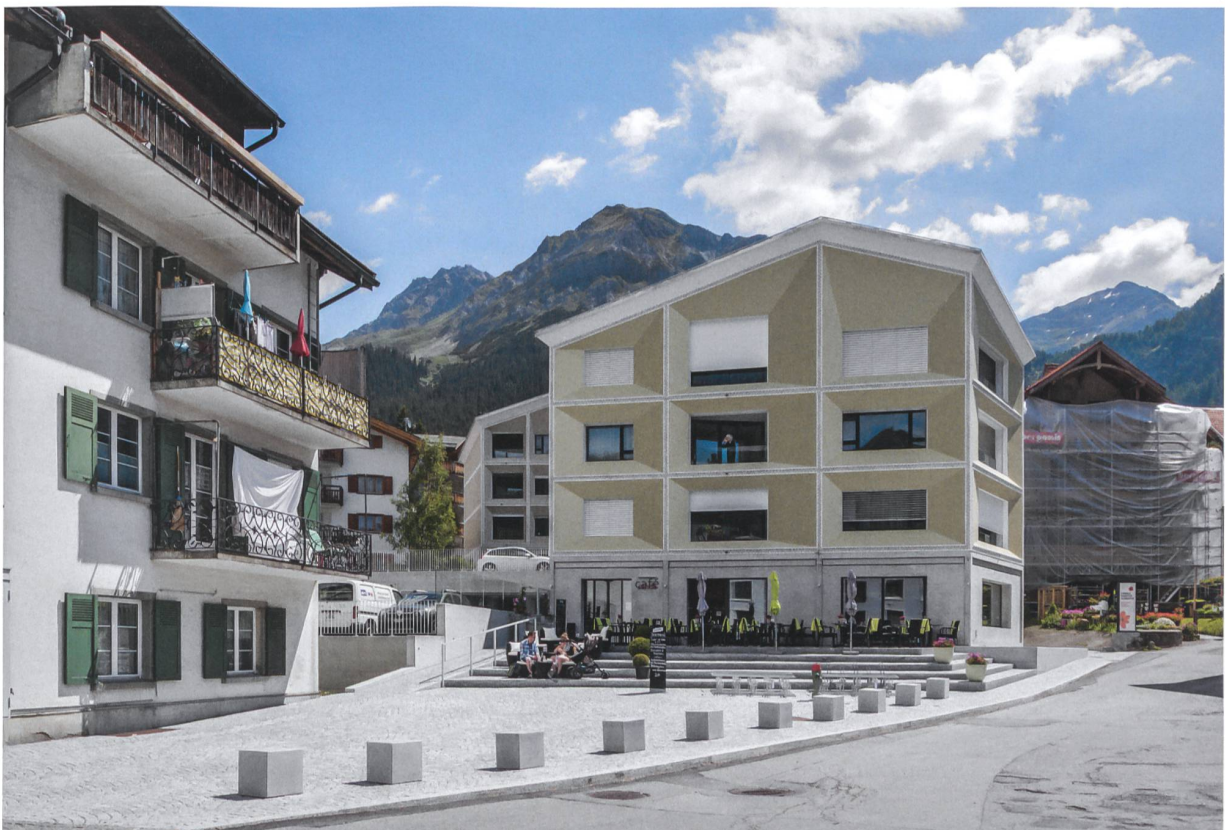
Die Wohn- und Geschäftshäuser neueren Datums sorgen, mitten im kommerziellen Zentrum der Lenzerheide, erstmals für kleinstädtisches, lebendiges Flair («Senda», Architektur: Ritter Schumacher, Chur; Bauingenieur: ewp, Chur; Baujahr: 2016).
