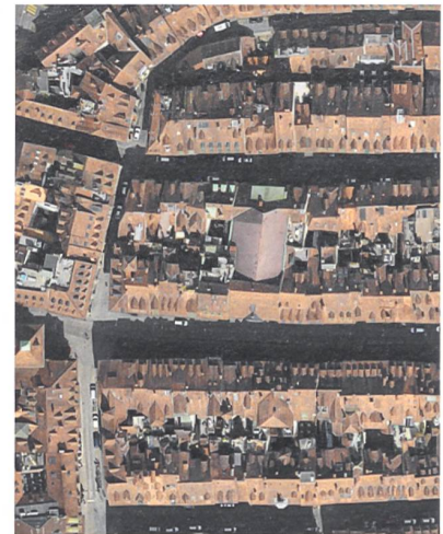
Historische Dachaufsicht mit Capitol in der Bildmitte.
