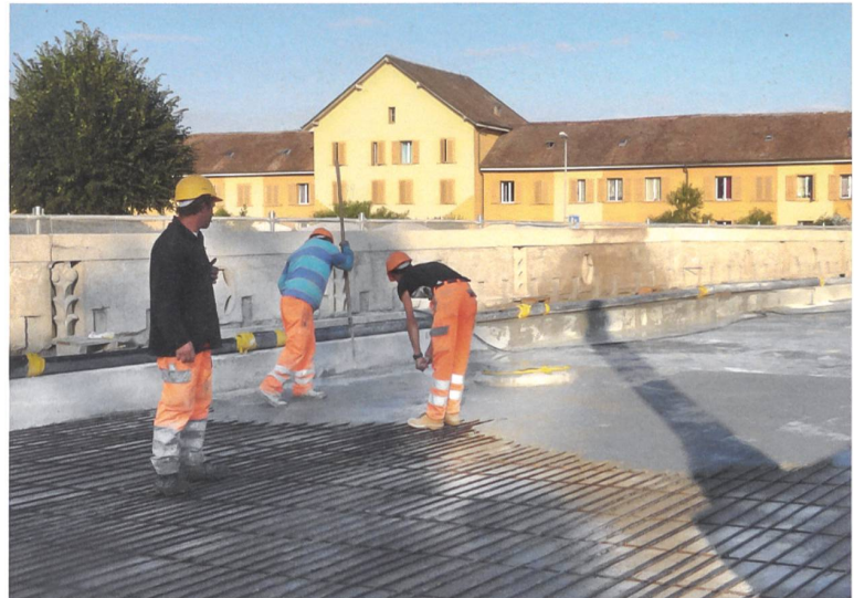
Einbau der 50 mm starken UHFB-Schicht bei der Guillermaux-Brücke in Payerne.
