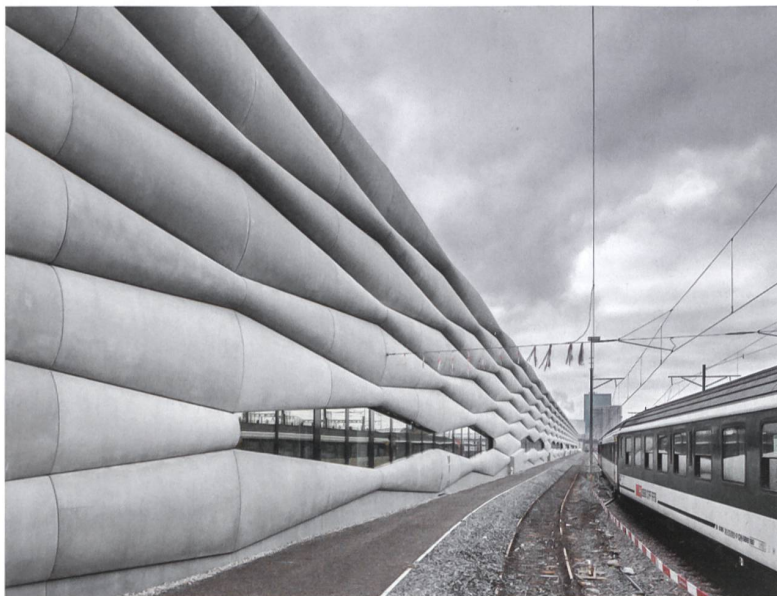
Die 420 m lange Fassade aus Glasfaserbeton der Serviceanlage Herdern flankiert das Gleisfeld vor der Einfahrt in den Zürcher Hauptbahnhof.
