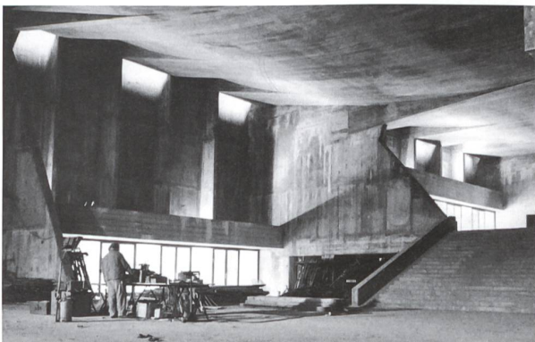
Oben: Provisorisch gefaltet: Überdachung der Kirchenruine in Bad Hersfeld während der Abwicklung der Membran. Darunter: Spannbeton-Hängedach des Stadttheaters Basel mit der Analogie zum gefalteten Baldachin im Bereich der Oblichter.
