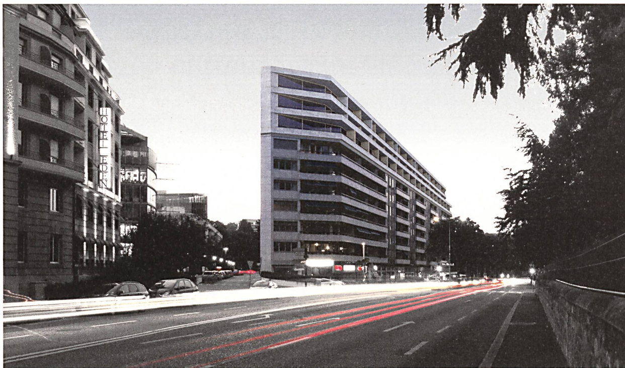
Aufstockung eines Gebäudes an der Rue de Lausanne in Genf (Architektur: Lacroix Chessex): Die Qualität des Siegerprojekts überzeugte den Kanton, eine Ausnahmebewilligung für eine höhere Ausnutzung zu erteilen.
