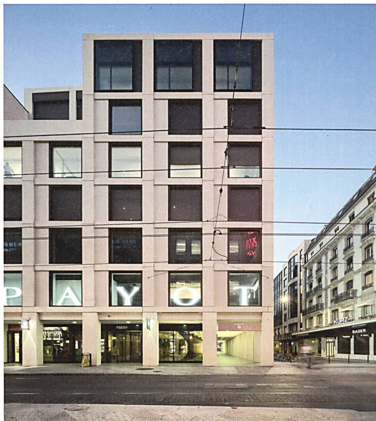
Umbau des Gebäudes Rhône 8 in Genf (Architektur: Richter Dahl Rocha & Associés architectes). Der Wettbewerb hat dazu beigetragen, die auch wirtschaftlich beste Lösung für den schwierigen Standort zu eruieren.
