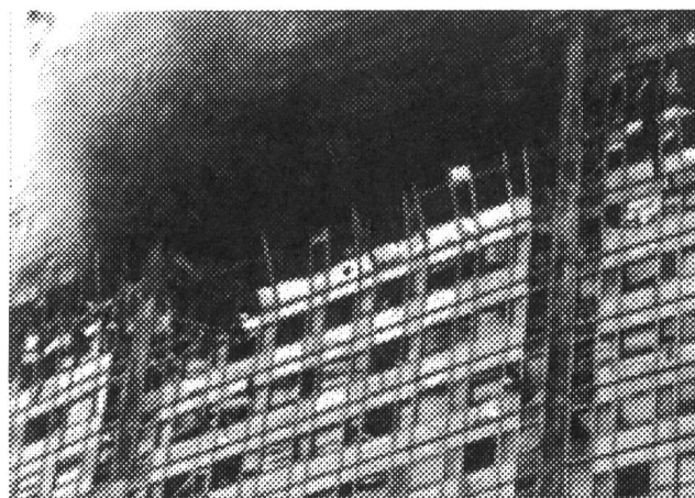
Die Einsturzstelle am 25. Stock des Pirelli-Hochhauses in Mailand (Bild Reuters)
