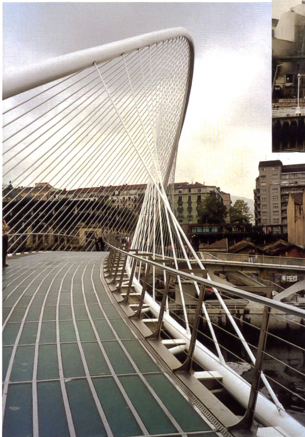
Faszination Brücke: Zubizuri-Brücke von Galatrava in Bilbao
