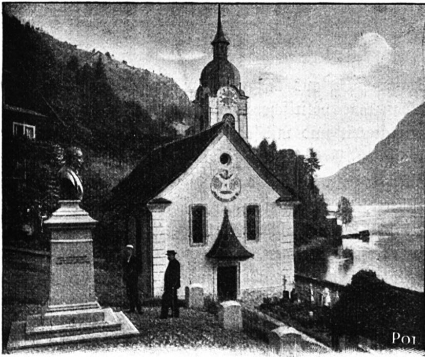
Kirche und Brunstig-Denkmal in Bauen.
