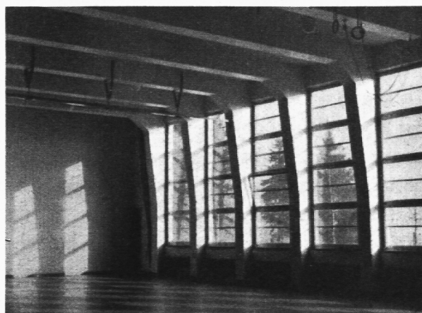
Halle in Eisenbetonkonstruktion.
