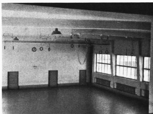
Vorteilhafte Disposition von Befensterung und Heizung.
