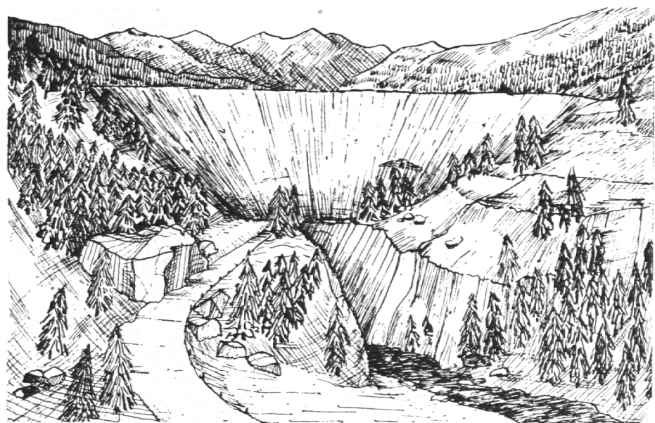
Damm-Humusböschung, luftseits. Alte Juliastraße. Aufgefüllte Schlucht. Julia-Austritt aus Grundablaß-Stollen.
