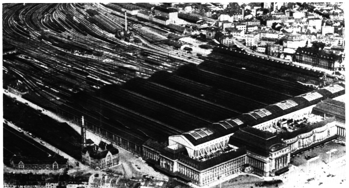
Flugbild des Leipziger Hauptbahnhofes, in den 26 Geleise einmünden. Die Hauptfront mißt 300 m. Um von einem Ende zum andern zu gelangen, hat man fast 4 Minuten zu marschieren. Aus »Die größten Bahnhöfe Europas«
