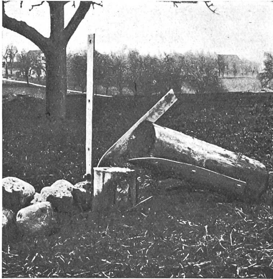
Fig. 5. Vom Sturme umgeworfene Stange auf Kastler-Sockel
