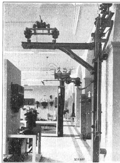
Fig. 14. Aus der 7. Abteilung: Freileitungsmaterial. Fahrleitungsmast.
