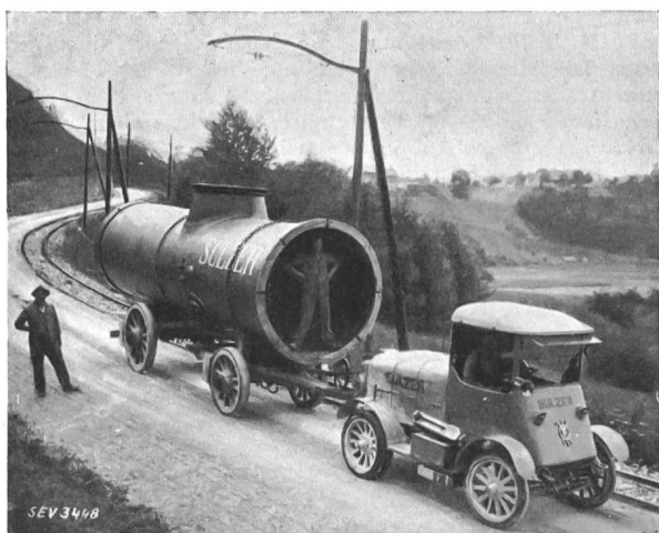
Fig. 3. Akkumulatortraktor. Zugkraft 10 t.
