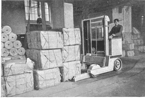
Fig. 15. Elektrostapler beim Abladen von Papierballen.
