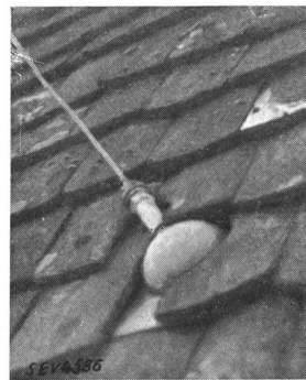
Fig. 3. Dachankereinbindung auf Ziegeldach.
