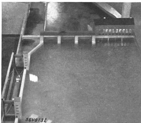
Fig. 6. Niederdruckwerk; links Schiffschleuse.
