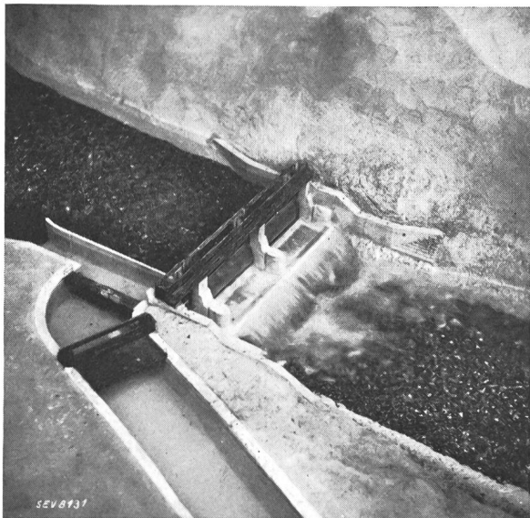
Fig. 5. Wasserfassung zum Mitteldruckwerk.
