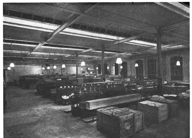
Fig. 4. Buntweberei Sirnach, Sirnach. Beleuchtung der Spulerei mittelst Mischlichtlampen HWA 500.
