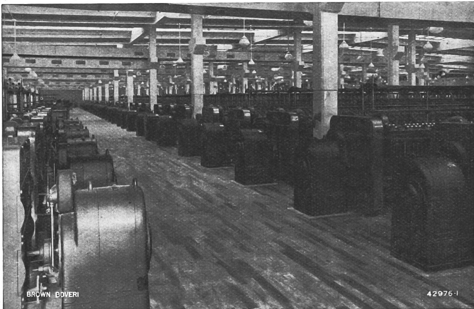
Fig. 7. Ringspinnmaschinen mit Nebenschluss-Kommutatormotoren und Spinnreglern.
