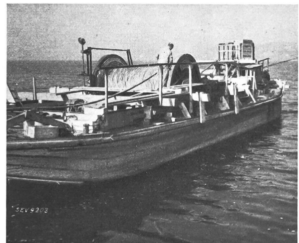
Fig. 6. Aufwickeln des Kabels auf dem Schiff.
