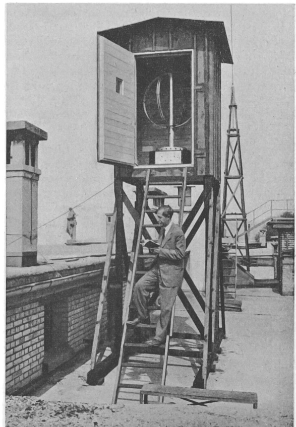
Fig. 3. Die Antennen des Goniographen auf dem Dach der Meteorologischen Zentralanstalt in Zürich
