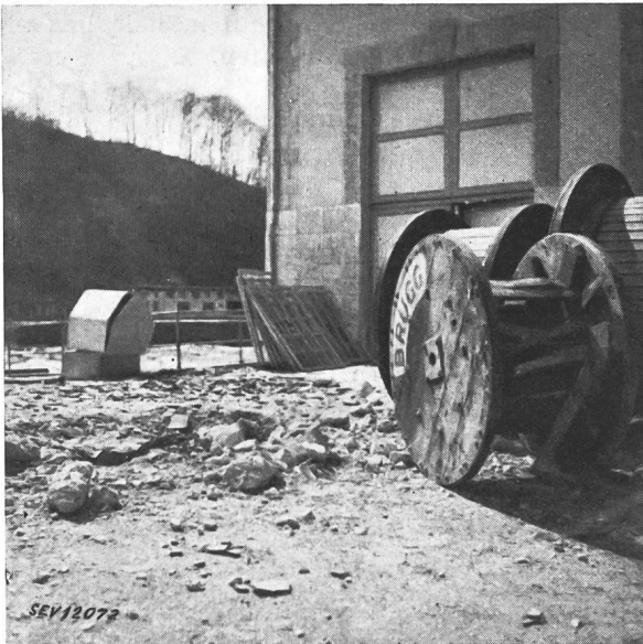
Fig. 13. Zerstörte Kabeltrommel
