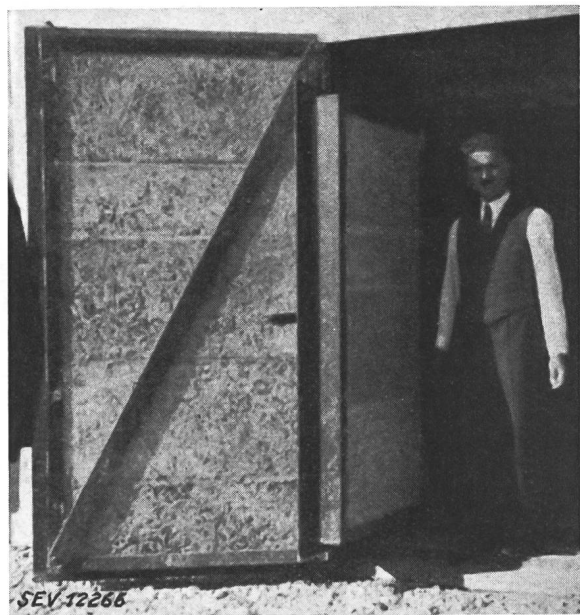
Fig. 8. Eingang in die schalldichte Umschalung des Transformators Fig. 7 Das Bild gibt einen Begriff von der Stärke der Wandkonstruktion.
