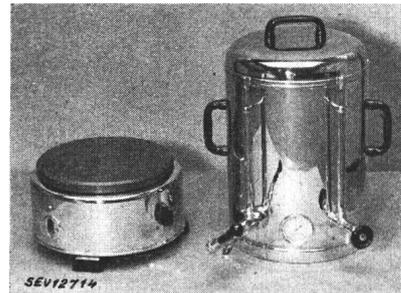
**Beschreibung:** Rechaud für Einrichtung zum Heisshalten von Kaffee, gemäss Abbildung. Gussplatte von 260 mm Durchmesser mit angepresstem Heizwiderstand auf Blechsockel befestigt. Kochherdschalter und Apparatestecker eingebaut. Die Einrichtung zum Heisshalten von Kaffee besteht aus einem Wasserbad aus Metall mit eingebautem Kaffeebehälter aus Porzellan von 6 l Inhalt.
