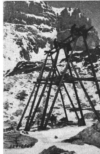
Fig. 9. Bockmast in Montage
