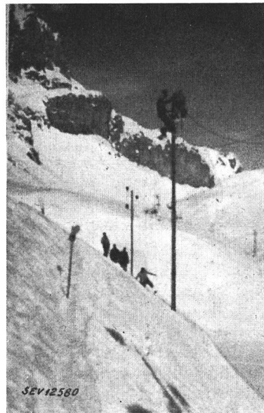
Fig. 20. Fertigstellen der Leitung am Steilhang über dem Daubensee am 19. November 1944
