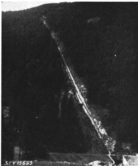
Das Tracé der Druckleitung bei Rothenbrunnen
