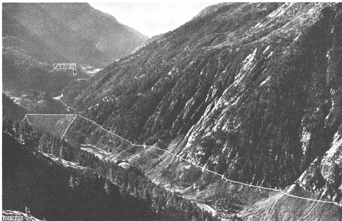
Fig. 5 Speicherbecken Sambuco, talabwärts
