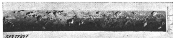
Fig. 7 Câble corrodé par électrolyse
