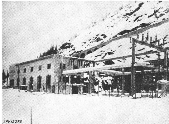
Fig. 6 Maschinenhaus mit Schaltanlage des Kraftwerkes Nore II
