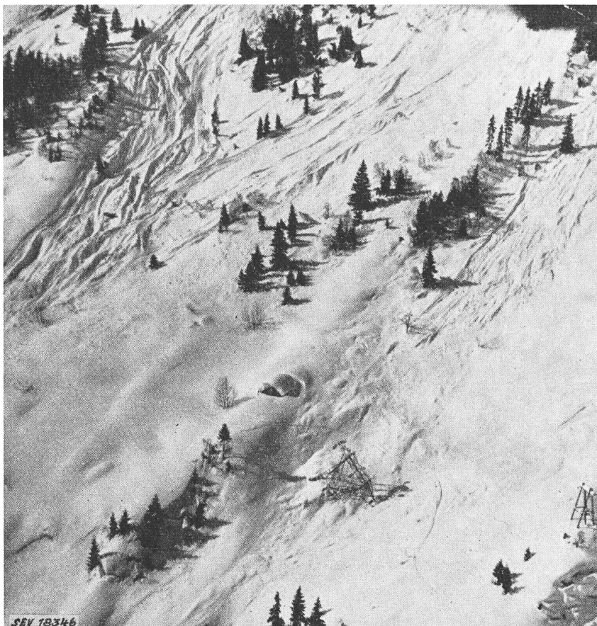
Fig. 5 Gotthardleitung westlich Airolo Der Mast Nr. 72 wurde durch die Lawine von Pian Secco zerstört (Rechts im Bild Holzmast einer 50-kV-Leitung)
