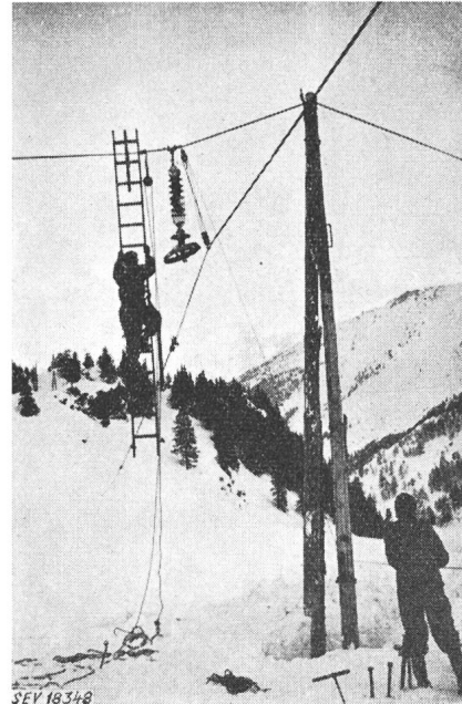
Fig. 7 Lukmanierleitung bei Acquacalda Provisorische Behebung des Unterbruches
