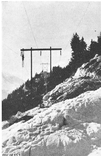
Fig. 12 Gotthardleitung Tragwerk aus Holz an der Unterbruchstelle bei Mast Nr. 49 oberhalb Piotta
