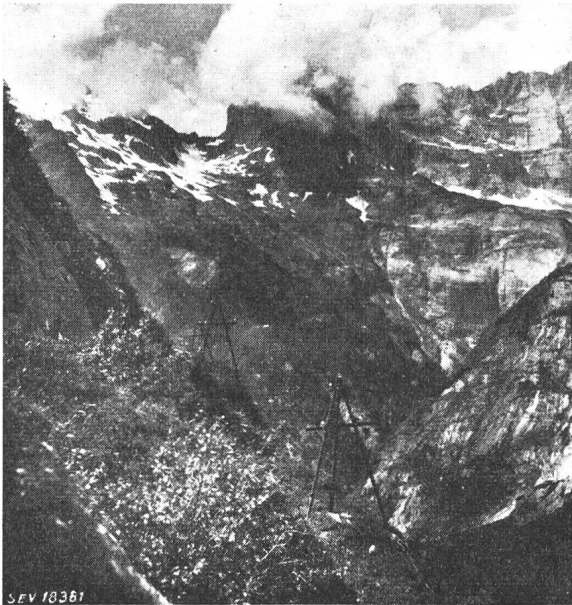
Fig. 1 Dreieck- und Pyramiden-Masten 16-kV-Leitung Innertkirchen-Gauli
