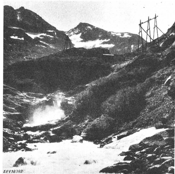
Fig. 2 Abspannstützpunkte 16-kV-Leitung Innertkirchen-Gauli
