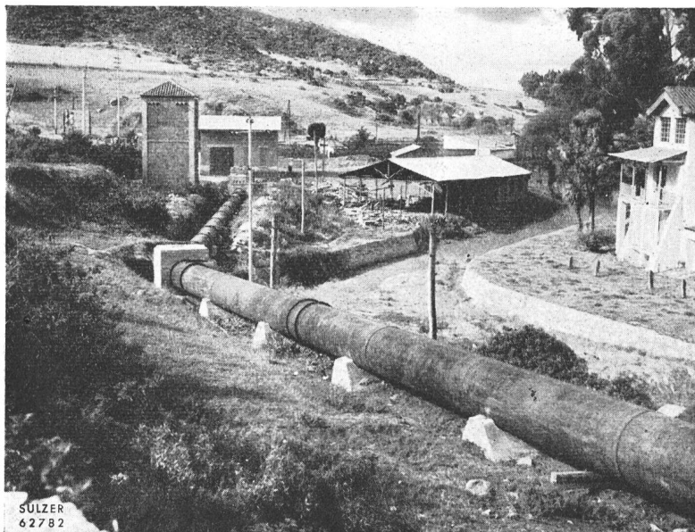
Die Druckleitung Im Hintergrund das Pumpwerkgebäude
