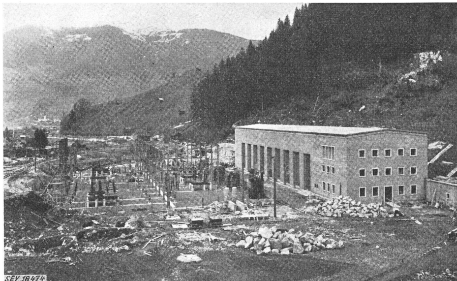
Fig. 6 Kraftwerk Uttendorf der ÖBB im Bau
