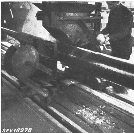
Fig. 2 Isolation d'une conduite d'eau (Zwahlen & Mayr, Lausanne)
