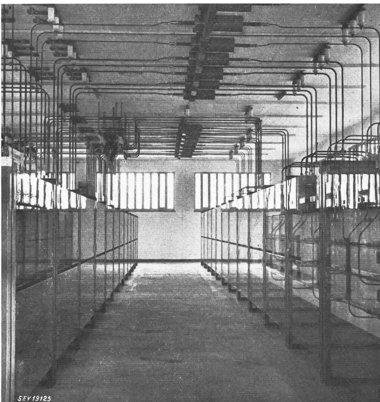
Fig. 7 Zu Revisionsarbeiten verschaltete 16-kV-Zelle
