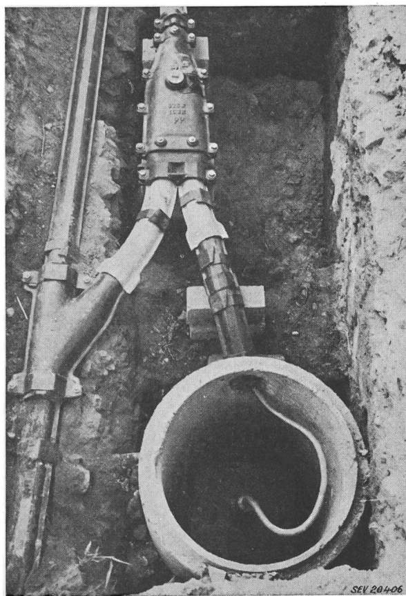
Fig. 1 Fernkabel mit Abzweigmuffe und Pupinschacht
