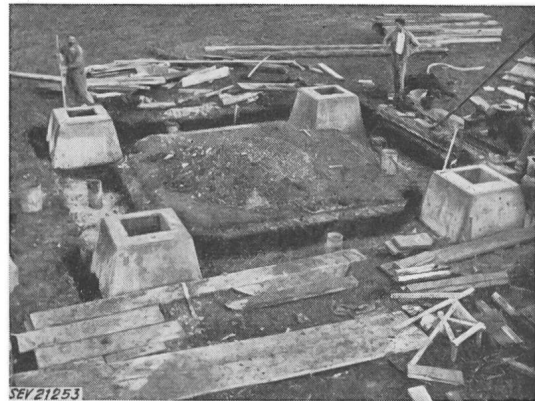
Fig. 12 Fundamentbau auf der 380-kV-Leitung Amsteg—Mettlen Rahmenfundament, Baujahr 1947
