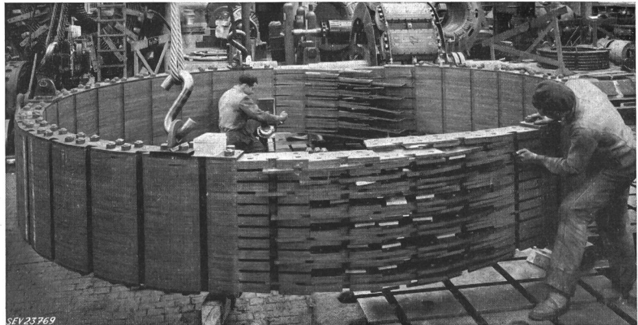
Fig. 10 Montage eines Paketrotors für Generator 32 000 kVA, 167 U./min Rjukan (Norwegen)
