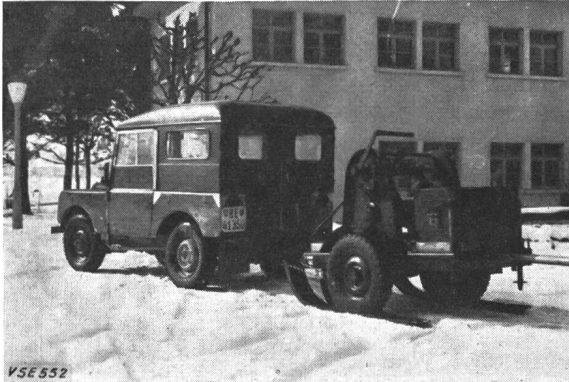
Fig. 8 Fahrzeug der Fig. 7 mit Bauwinde
