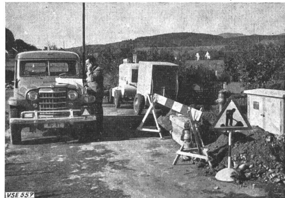
Fig. 3 Jeep des Chefmonteurs für Freileitungs- und Kabelbau auf einer Baustelle Beantwortung eines radiotelephonischen Anrufes
