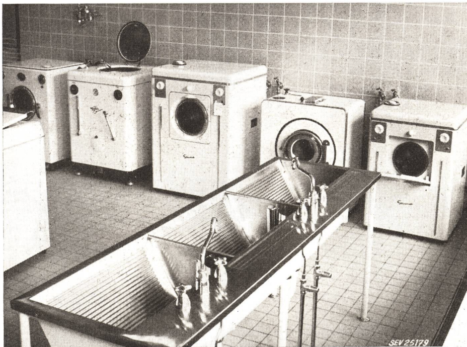
Fig. 7 Teilansicht der Vorführungswaschküche
